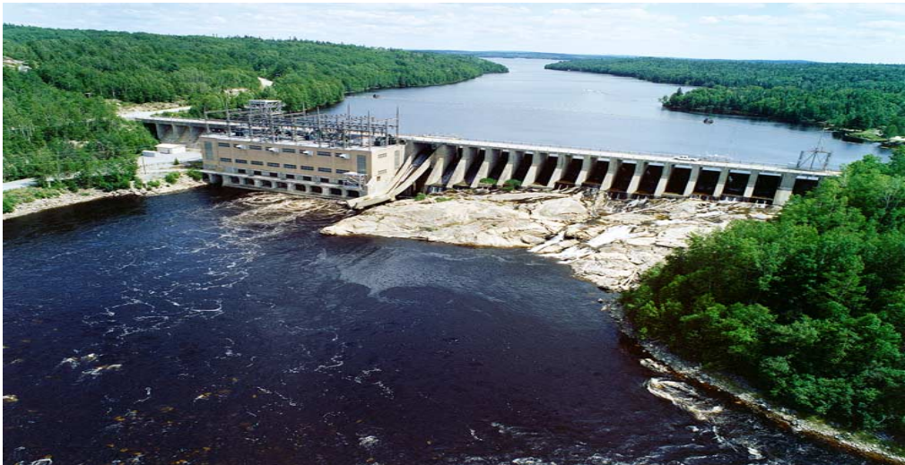
La centrale de Rapide-2 avant les travaux de réfection prévus de 2023 à 2027. Hydro-Québec.
