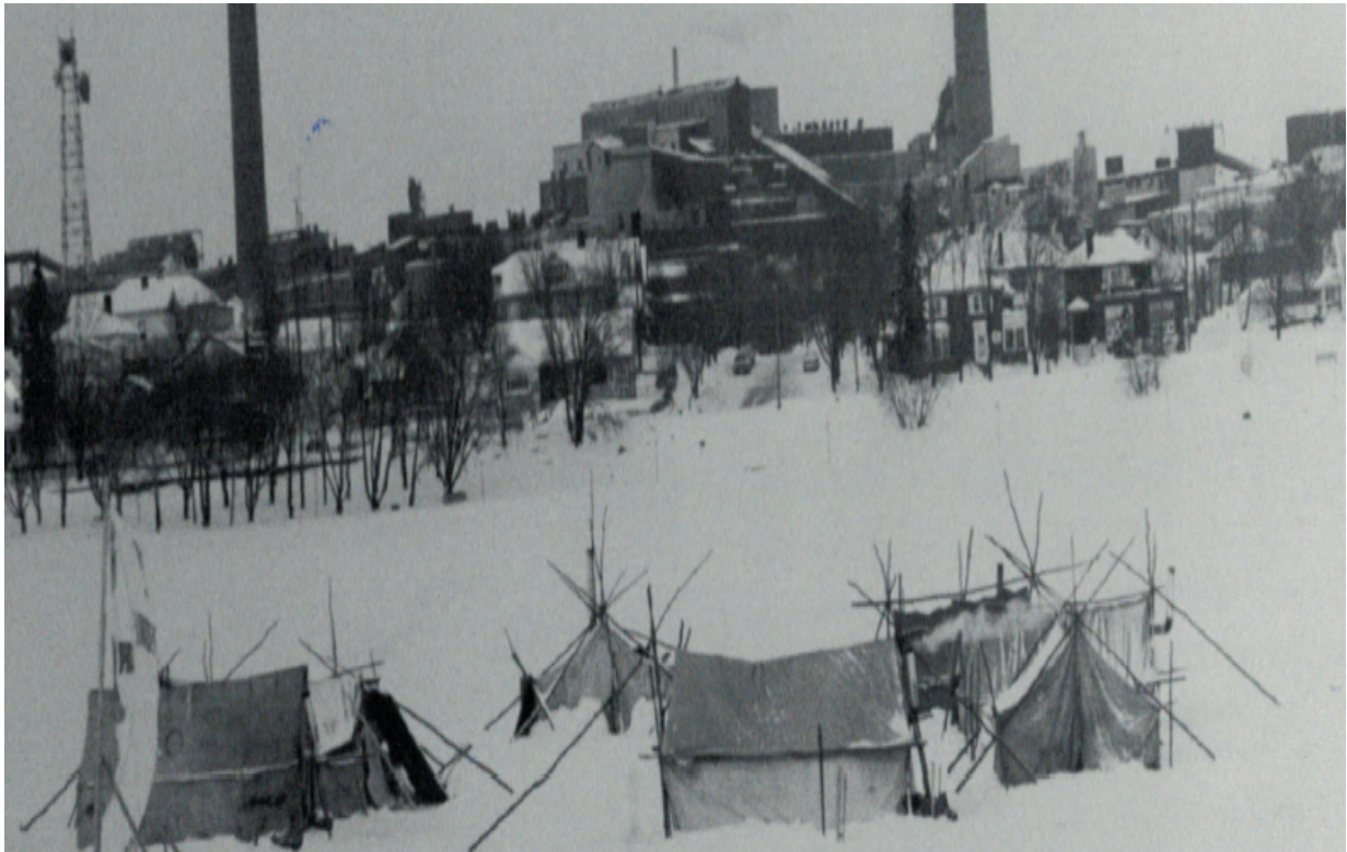
Le campement de l'Opération -30 sur le lac Osisko en février 1985. Bibliothèque et Archives nationales du Québec, Rouyn-Noranda.
